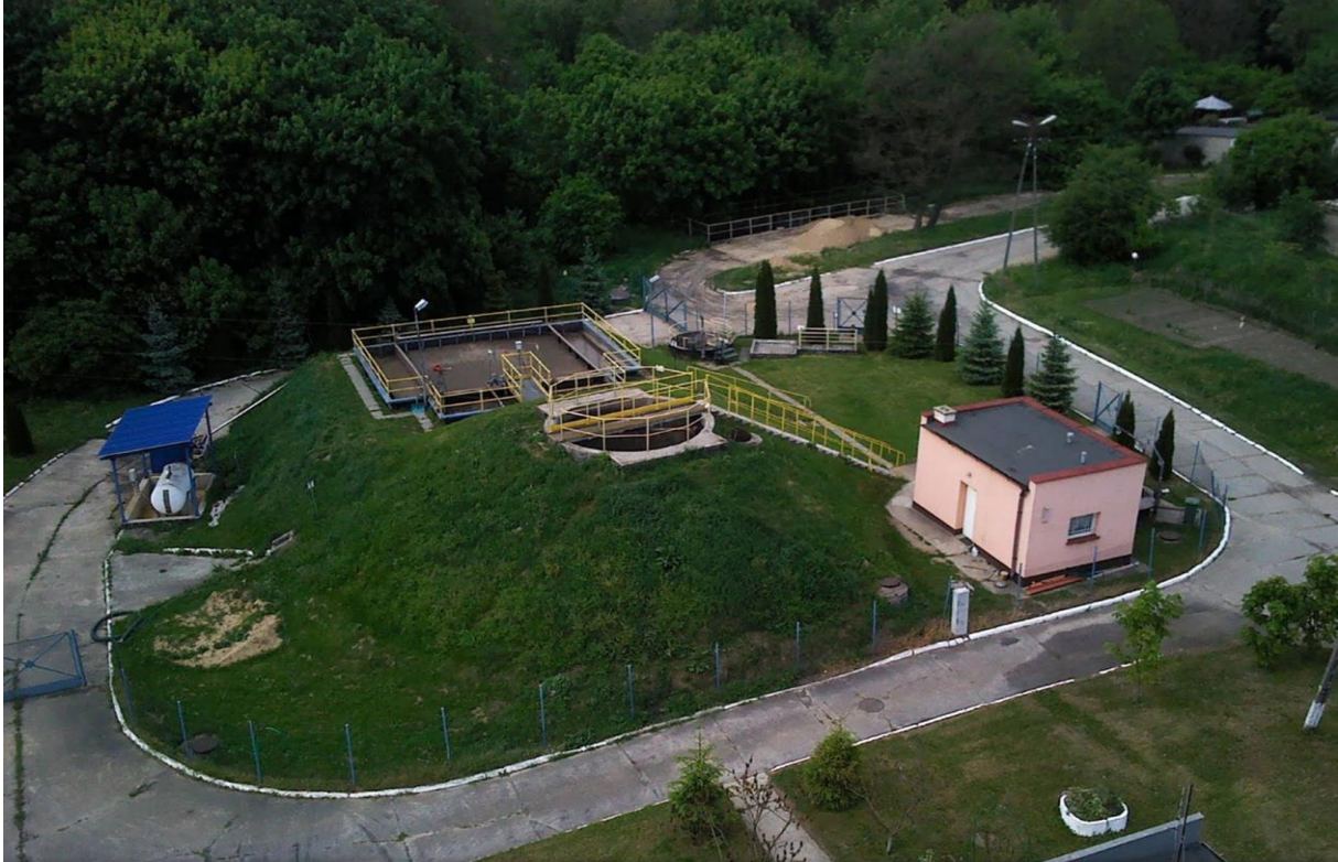
Fot. 1 Gminna oczyszczalnia ścieków w Osieku źródło: http://maps.google.com
